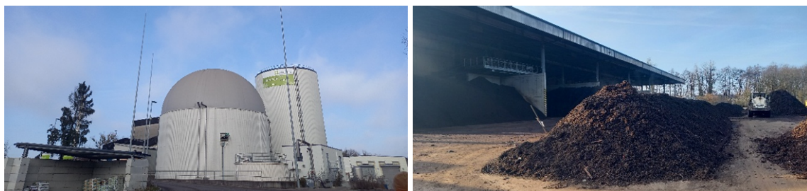
Kombinierte Vergärungs- und Kompostierungsanlage für Bioabfälle der RETERRA Hegau-Bodensee GmbH in Singen
